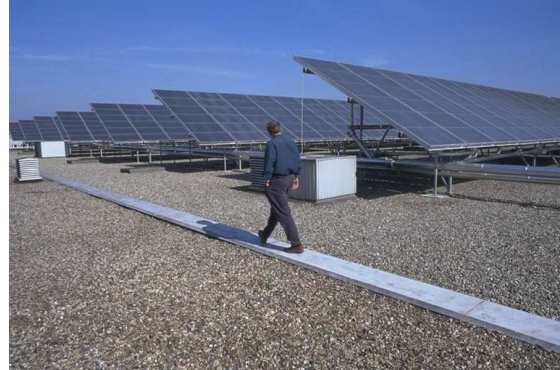
Thermische zonne-energie in een industriële toepassing: 1000 m 2 collector voor een snoepjesfabriek.
