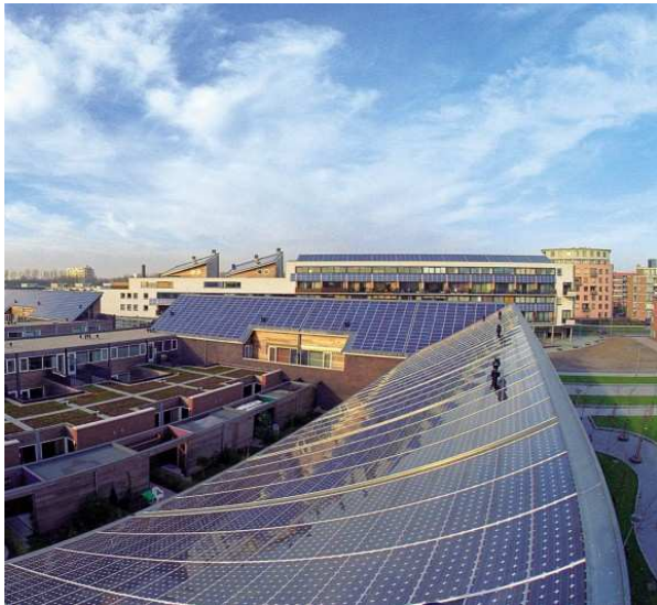
Toepassing van netgekoppelde zonnestroom in de woningbouw.
